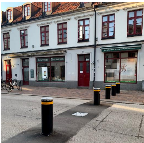
Höj- och sänkbara pollare sattes upp vid Maria Torg i samband med ombyggnaden. Det har nu satts upp ytterligare sådana på Södra Storgatan och Möllegränden.
