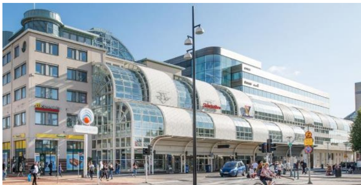
Före ombyggnaden entré mot Kungstorget.
