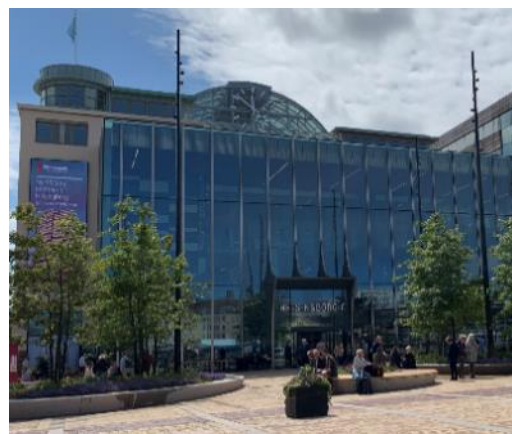
Huvudentré efter ombyggnad.
