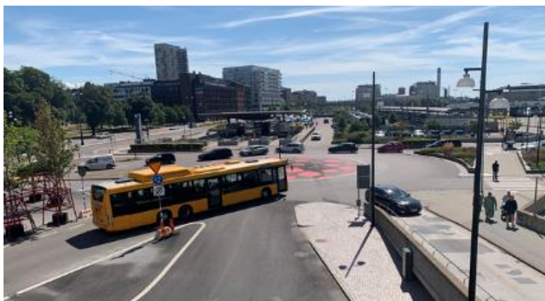
Vid rondellen i södra delen saknas "stop-and-go" för snabb avlämning och upphämtning. Det är en komplex trafiksituation med många olika trafikslag som möts i en högt trafikerad rondell.
