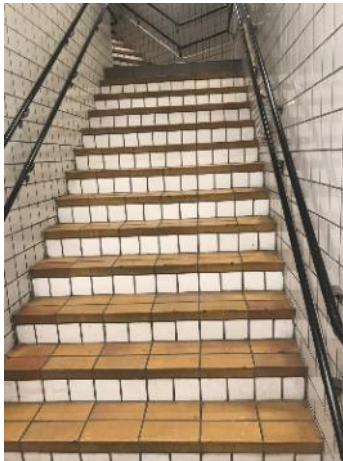
Material i trappa före ombyggnad.
