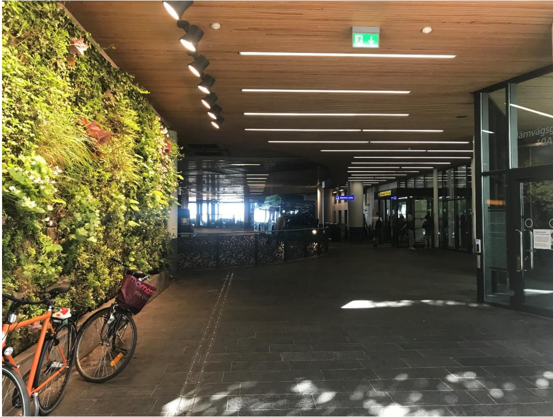
Renoverad ingång till bussterminal och Helsingborg Central från Järnvägsgatan. Sommaren 2018
