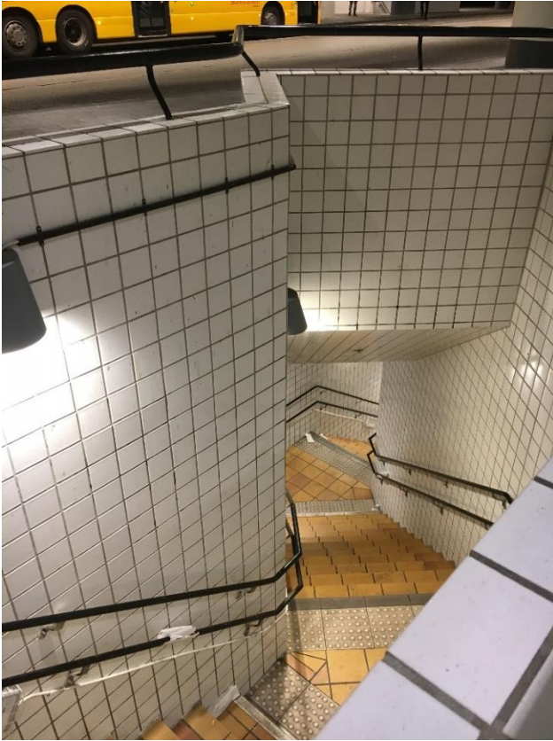
Trappa till perrongerna i bussterminalen. Svängd och med dålig översikt. Oktober 2017 vid nulägesanalysen
