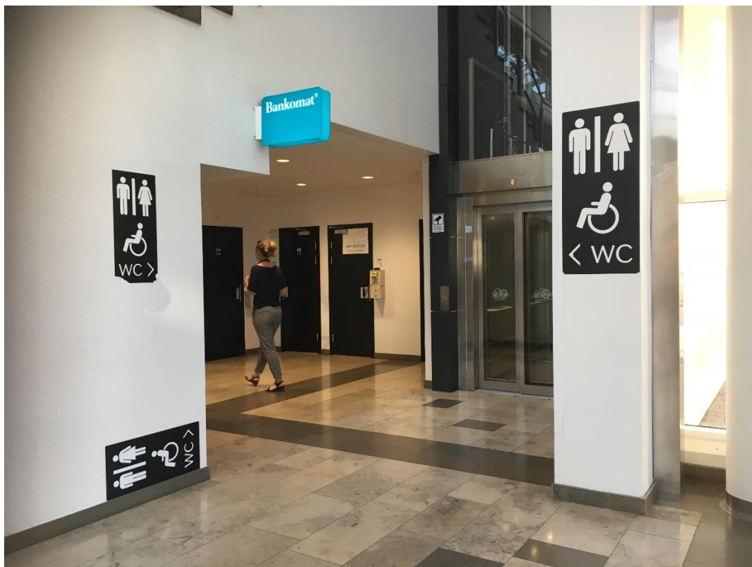
Plan 1 toaletter och bankomat under rulltrappan. Sommaren 2018 före ombyggnad av Helsingborgs central – toaletterna är nya och byggdes i samband med kontorstillbyggnaden i etapp 1
