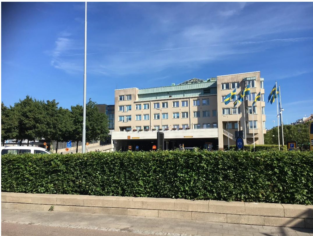
Vy från södra uppgången mot Helsingborg Central/bussterminalen och ramp upp till P-däck. Sommaren 2018
