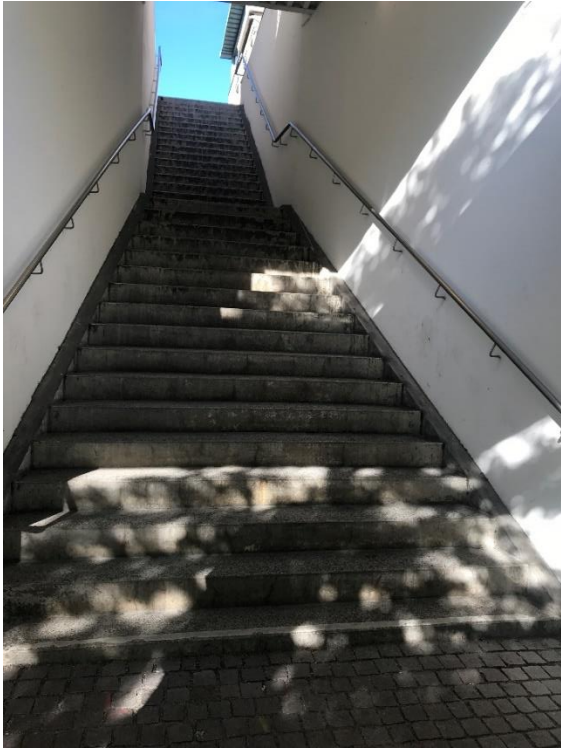
Trappa upp till P-däck/entré plan 2 från Järnvägsgatan. Sommaren 2018 före ombyggnad
