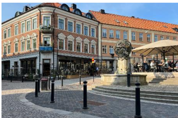
Norra Storgatan efter ombyggnad 2023.
